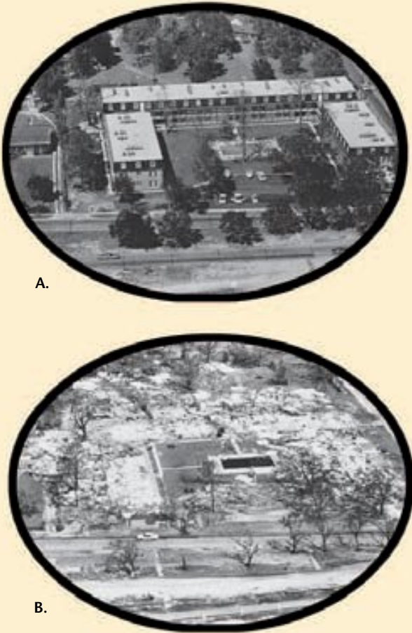
▲ Figura 20.B En 1969 el huracán Camille azotó la costa del Mississippi. Se trató de una infrecuente tormenta de categoría 5. Estas fotografías clásicas documentan la fuerza devastadora de un oleaje de temporal de 7,5 metros del temporal en Pass Christian. A. Los apartamentos Richelieu antes del huracán. Este edificio de tres plantas de aspecto sólido se encontraba justo al otro lado de la carretera de la playa. B. Los mismos apartamentos después del huracán. (Propiedad de Chauncey T. Hinman.)
