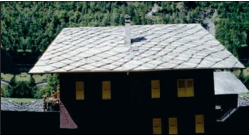
◄ Figura 8.10 Dado que la pizarra se rompe en capas planas, tiene varios usos. Aquí, se ha utilizado para construir el techo de esta casa en suiza (Foto de E. J. Tarbuck.)
