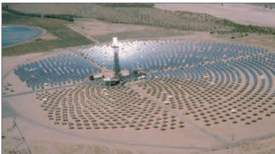
◀ Figura 21.12 Solar One, instalación solar utilizada para generar electricidad en el desierto de Mojave cerca de Barstow, California. (Foto de Thomas Braise/The Stock Market.)
